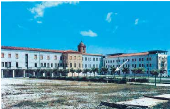
Sassoferrato (AN), convento “La Pace”, dove il Servo di Dio è passato a miglior vita (2 ottobre 1969). Particolare della camera, indicata con la freccia.
